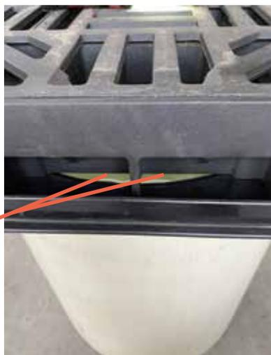
Hier kann beim Betonieren der Beton durch die Öffnungen in den Schacht laufen. Um dies zu verhindern werden 4 Stücke Schaumstoff mitgeliefert, die **vor** dem Betonieren in die Ausschnitte gesteckt werden. (s.Foto)
