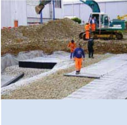
Anschließend die verleg- ten Blöcke und die Ventilationsschicht komplett mit dem Geotextil bzw. der Folie umhüllen. Da keine Fehlstellen entstehen dürfen, bitte auf eine sorgfältige Überlappung achten. Die Überlappungen der Folie ordnungsgemäß verschweißen.
