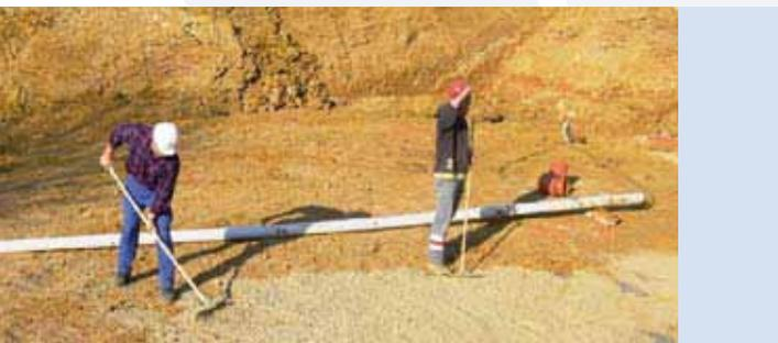
Das Erdplanum gemäß der Planunterlagen erstellen. Es gelten die Bestimmungen der DIN 18300 „Erdarbeiten“ und DIN 4124 „Baugruben und Gräben“. Für die Versickerung muss die Durchlässigkeit der verdichteten Schicht gleich oder größer als der anstehende Boden sein.
